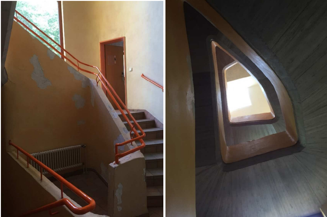
Das hintere Treppenhaus, 4 ½ Etagen
